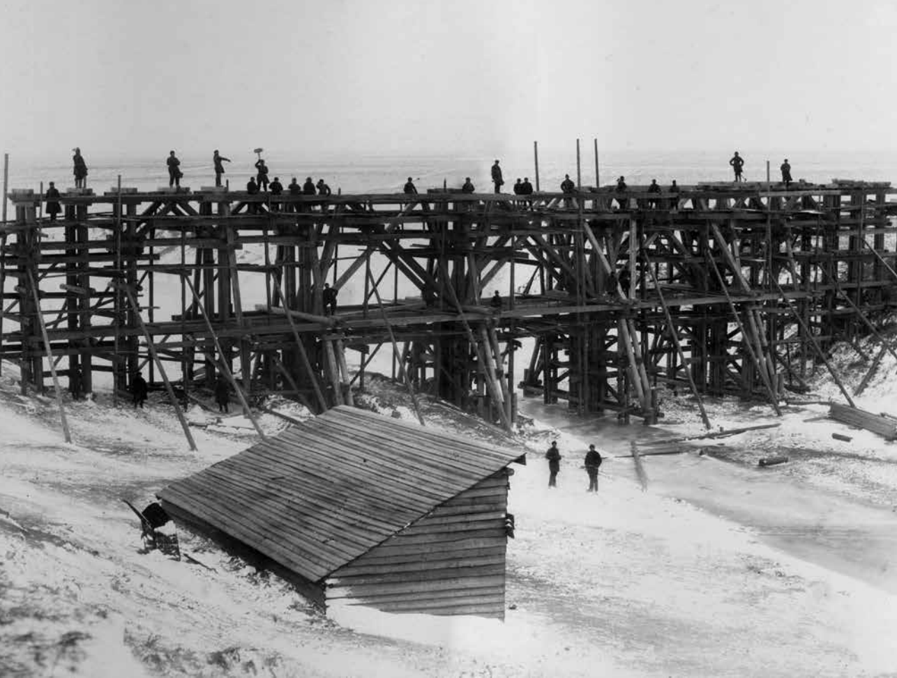
Строительство железнодорожного моста
