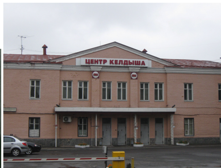
Здание в Москве (сейчас Центр им. Келдыша), где в 1930-х гг. был РНИИ.
